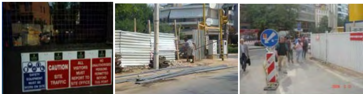
Εικόνες 12.7 Σήμανση σε εργοτάξια
