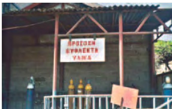
Εικόνα 5.3: Σήμανση εύφλεκτων υλικών
